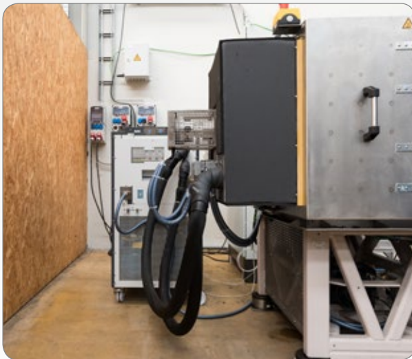
Fig. 7: boîtier isolé du transformateur de chaleur.
