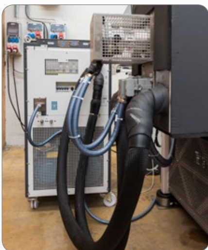
Fig. 5: Motore del ventilatore applicato all'esterno dell'involucro
